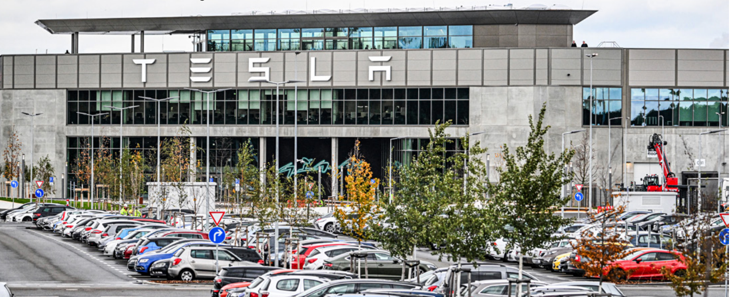
Tesla-Fabrik in Brandenburg
